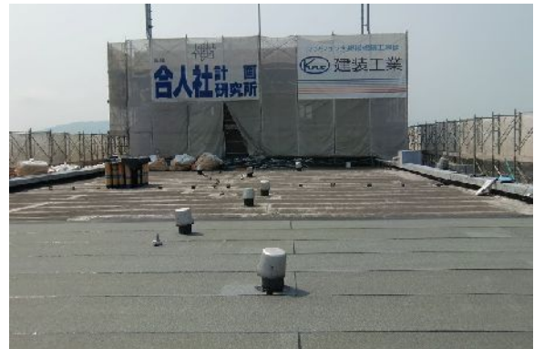
屋上防水工事
