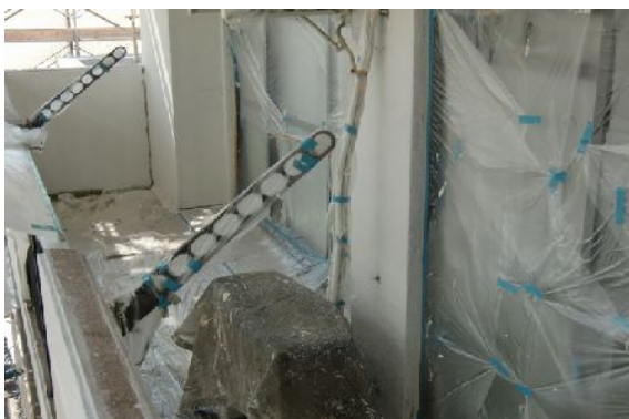
バルコニーの塗装工事
