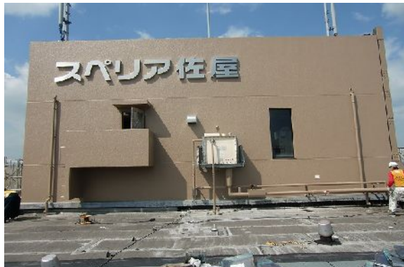
塔屋部分の足場解体後
