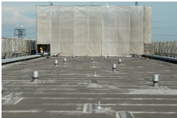
屋上の防水工事前
