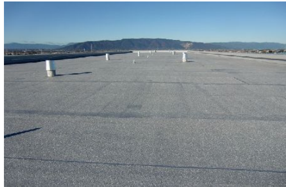
屋上防水工事完了
