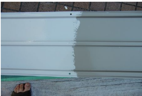
共用館の屋根に塗った遮熱塗料見本
