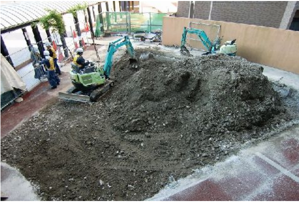
プレイロットの解体
