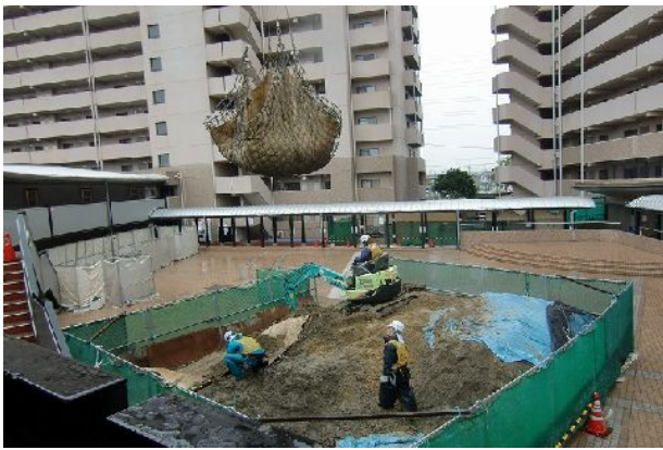
土砂の仮置場
