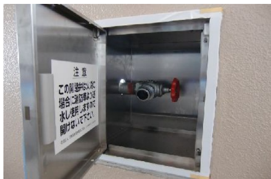
消防隊専用放水口
