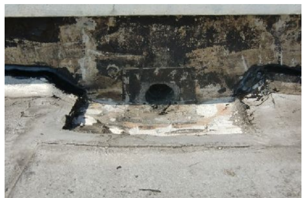
屋上の雨水排水口
