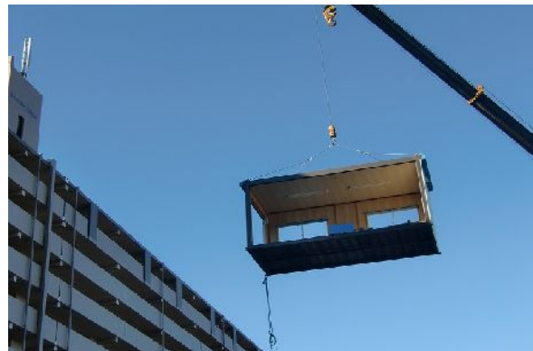
仮設事務所の解体・搬出
